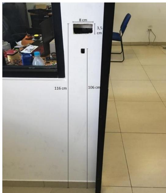
*Figura 48.* Altura para pantalla y lector de huella
