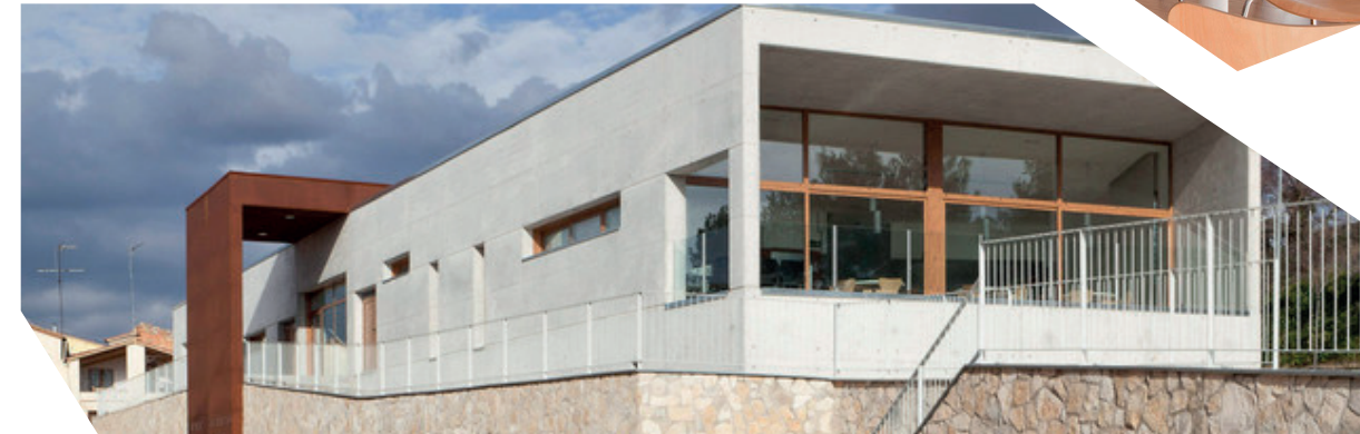
Figura 80. Vista exterior. Tomado de (Plataforma Arquitectura, 2016)
