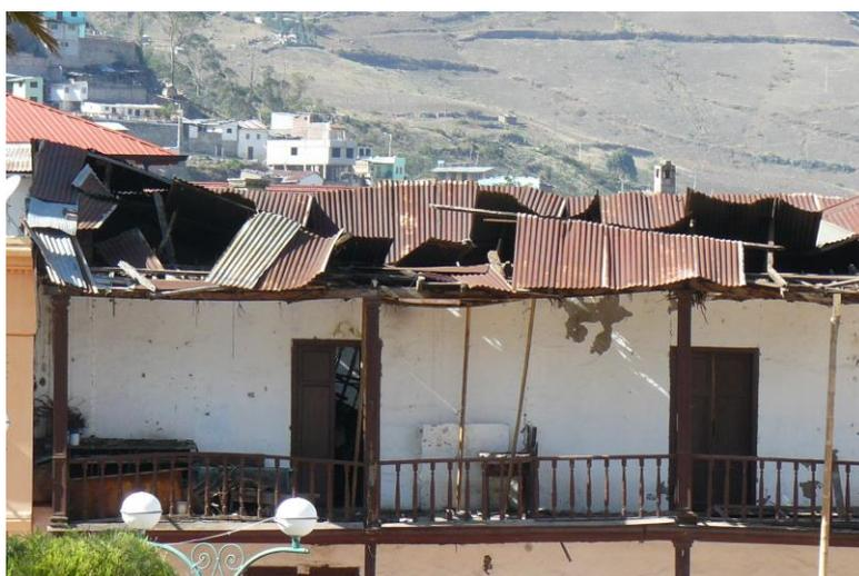
*Figura 3. Cubierta en mal estado, Fachada calle Quito*
