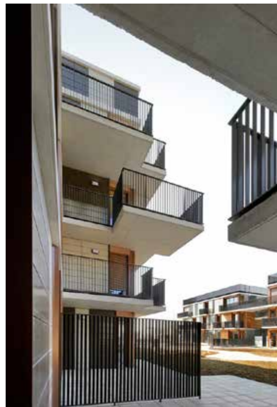
Figura 113. Espacio Público. Tomado de "Plataforma Arquitectura", 2013.
