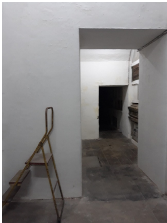
Anexo 36. Bóveda 2 – Iglesia de San Francisco
