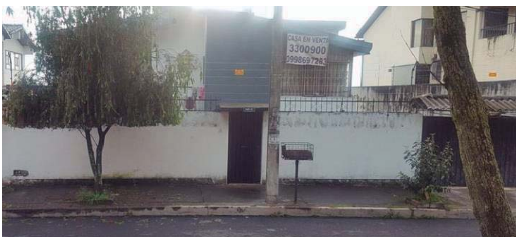
Figura 96. Cerramiento de la casa
