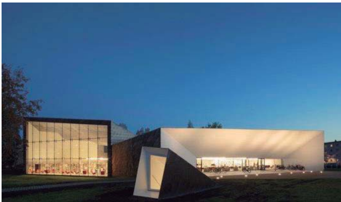
Figura 46. Fachada de noche
