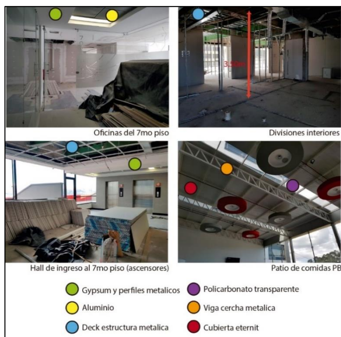
Figura 87. Cielos rasos existentes en la edificación
