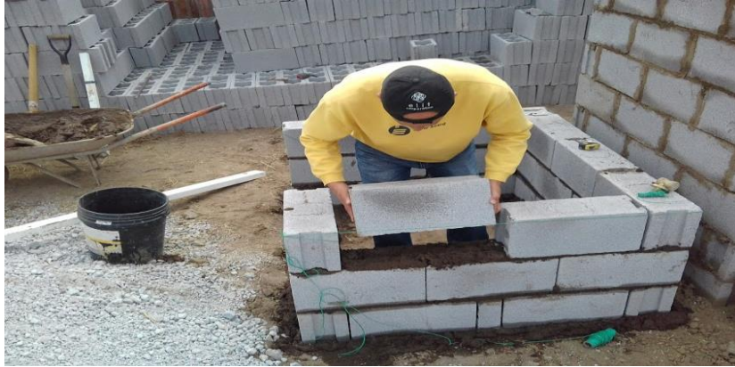
Término 3ra. hilera área de prueba sin aserrín pulverizado
