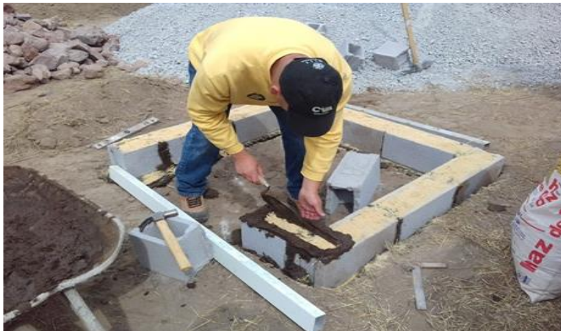
Colocación de mezcla sólo perímetro de bloques para no mojar el aserrín pulverizado
