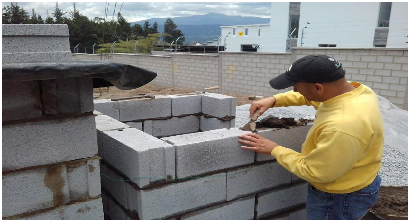
Puesta de mezcla o argamasa entre bloques 8va. hilera de área de prueba sin aserrín pulverizado
