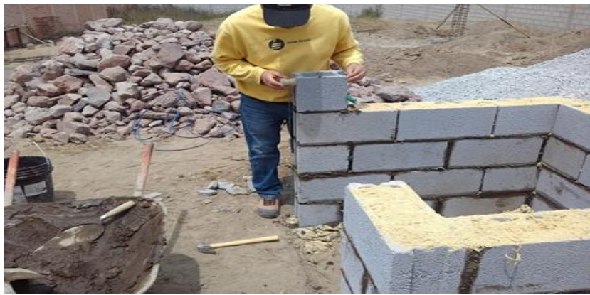
Colocación bloque inicio 5ta. hilera utilizando plomada
