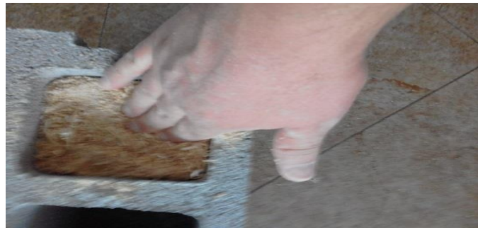
Figura 24 Introducción final del aserrín pulverizado dentro de orificio del bloque.
