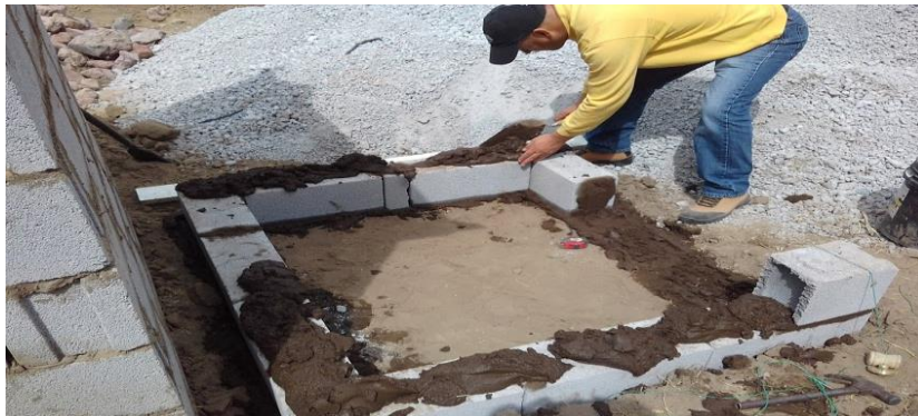
Inicio construcción normal 1ra. Hilera de área de prueba sin aserrín pulverizado
