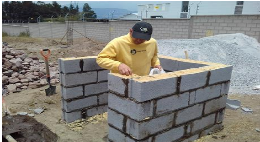
Introducción aserrín pulverizado 5ta. hilera de bloques
