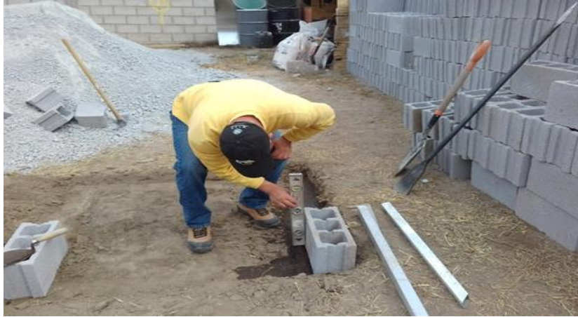
Nivelado vertical de primer bloque inicio primera hilera
