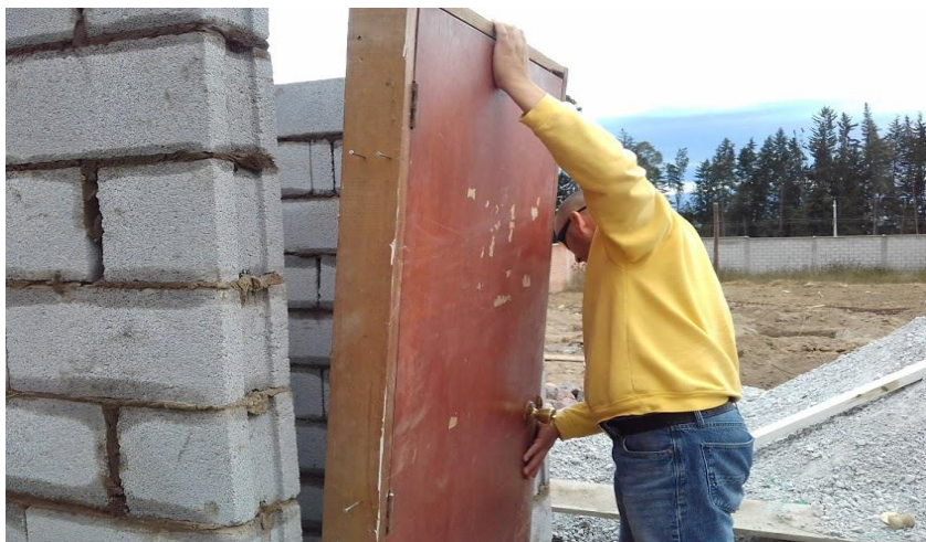
Colocación de puerta en área de prueba sin aserrín pulverizado
