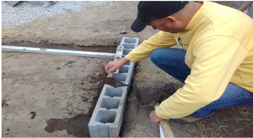
Relleno con mezcla espacios entre bloques de primera hilera pared lateral
