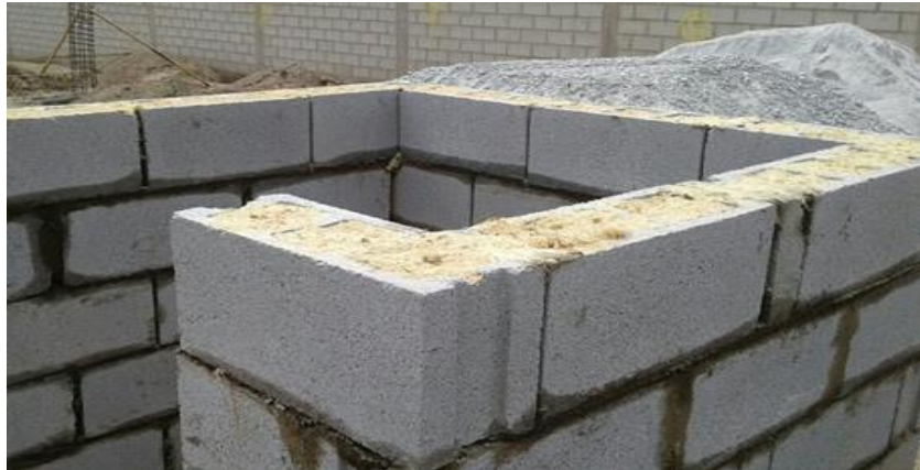
6ta. hilera de bloques con aserrín pulverizado
