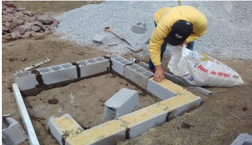
Introducción de aserrín pulverizado 1ra. Hilera
