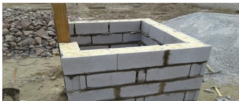
Puerta colocada terminada 6ta. Hilera
