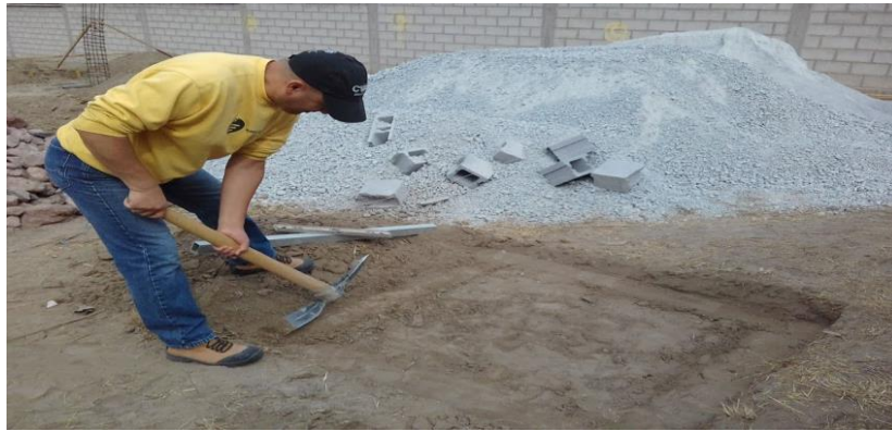
Nivelación del terreno 1
