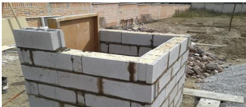
Primer bloque inicio 9na. hilera de bloques
