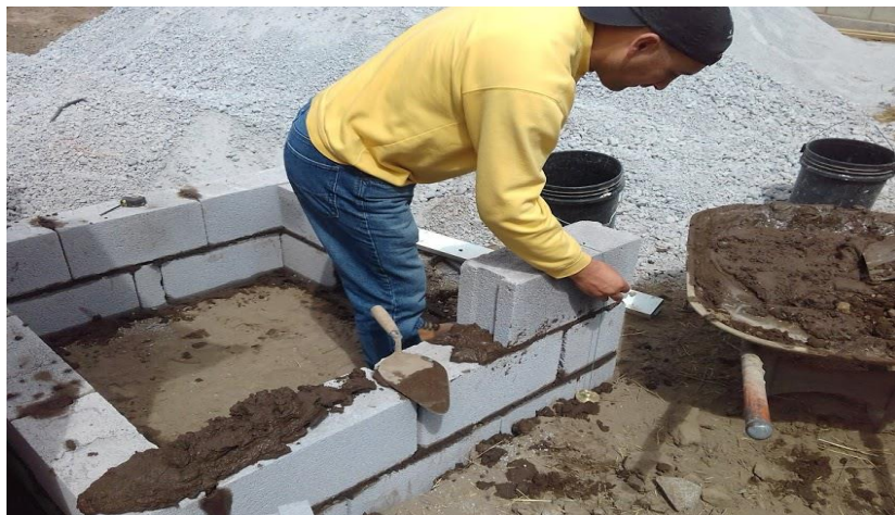
Plomada inicio 3ra. hilera de área de prueba sin aserrín pulverizado
