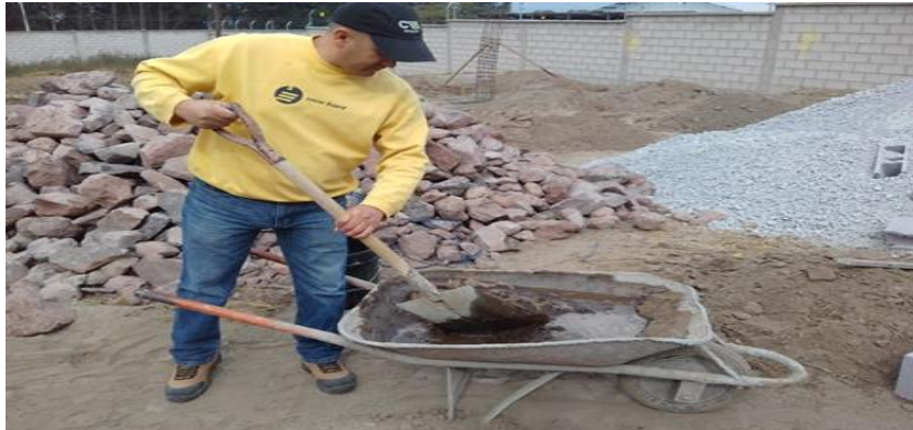
Preparación de mezcla utilizando tierra limpia y agua
