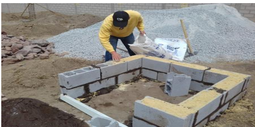
Introducción aserrín pulverizado en 2da. hilera de bloques
