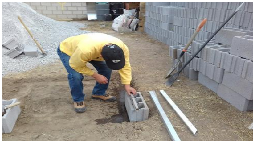
Nivelado horizontal de primer bloque inicio primera hilera
