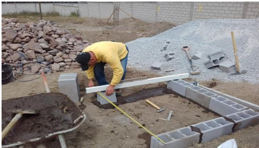
Nivelación horizontal y vertical de primera hilera pared opuesta
