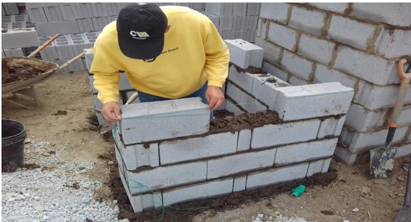
Nivelada 4ta. hilera área de prueba sin aserrín pulverizado
