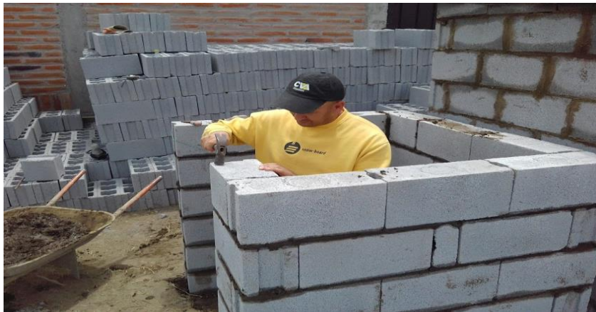
Término de 6ta. hilera área de prueba sin aserrín pulverizado
