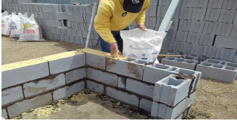
Introducción de aserrín pulverizado en 3ra. hilera de bloques
