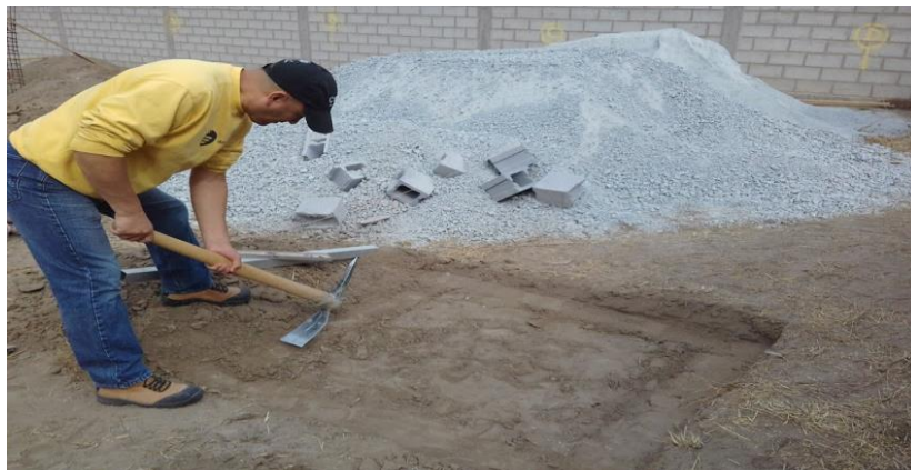
Nivelación del terreno 2
