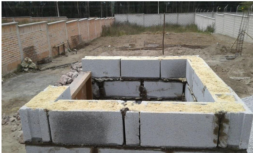
10ma. hilera de bloques introducida aserrín pulverizado
