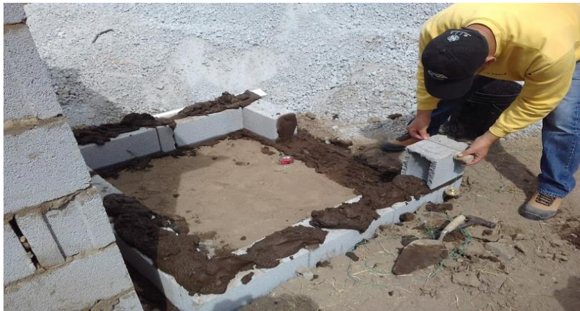
Nivelada 2da. hilera de área de prueba sin aserrín pulverizado
