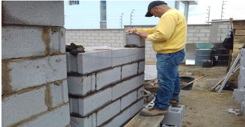
Inicio de 7ma. hilera de área de prueba sin aserrín pulverizado
