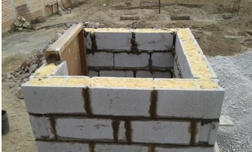
9na. hilera introducido aserrín pulverizado
