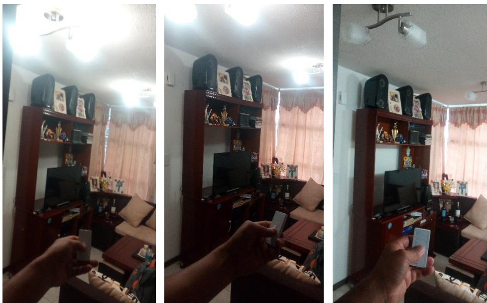
Figura 100. Funcionamiento de las luminarias de la sala
