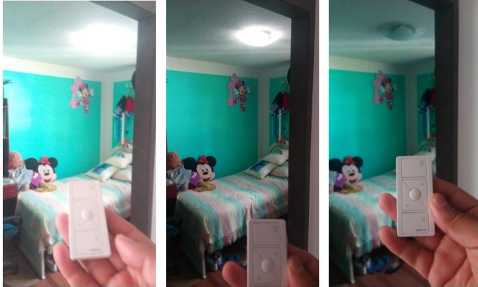
Figura 99. Funcionamiento de luminaria de dormitorio N°2
