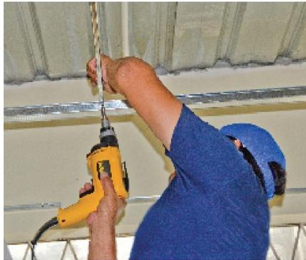
Figura 14 Colocación de tornillos en el tumbado
