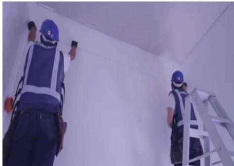
Figura 21 Trazado en todo el perímetro
