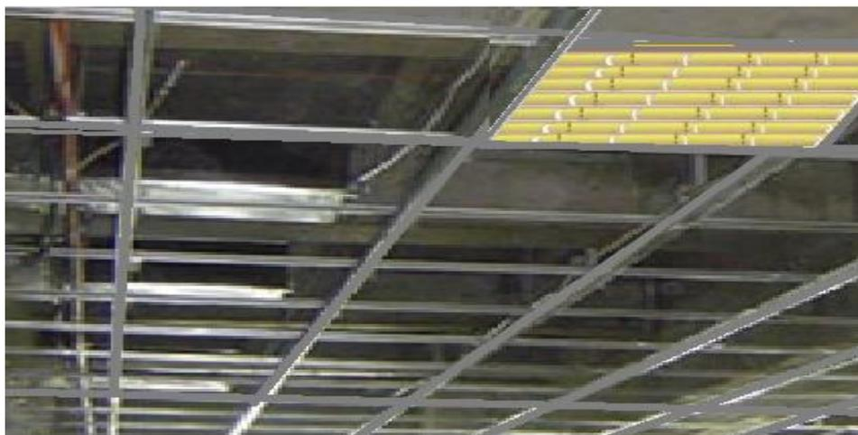
Figura 120 Estructura del cielo falso.
