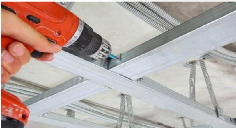
Figura 117 Instalación de perfiles
