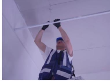
Figura 23 Sujeción de perfiles al tumbado
