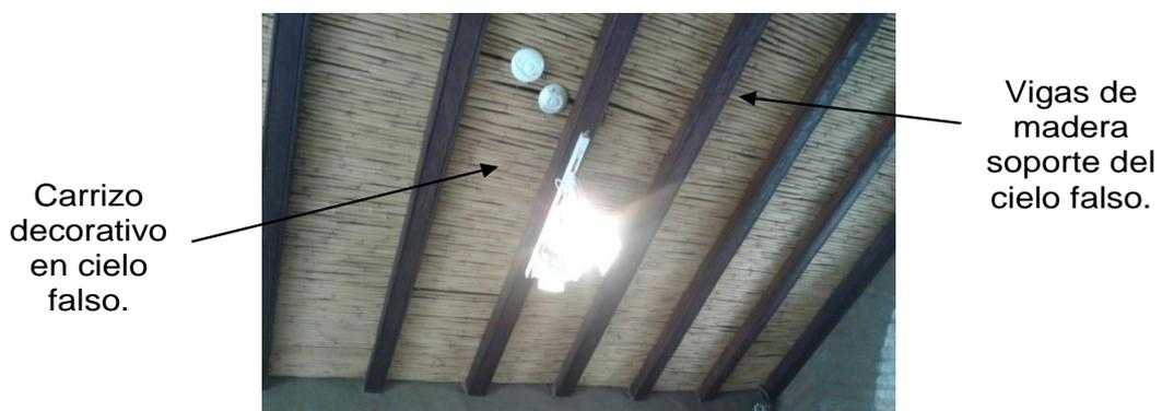
Figura 5 Detalle de cielo falso con carrizo.
