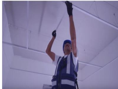
Figura 24 Colocación de perfiles secundarios
