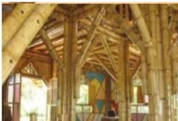
Figura 39 Aplicación de la caña guadua como estructura.
