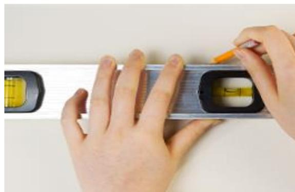
Figura 116 Trazo en paredes
