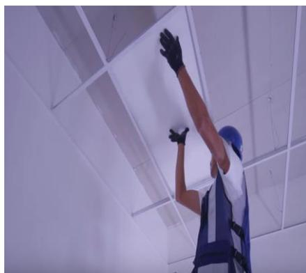
Figura 25 Instalación de paneles Armstrong
