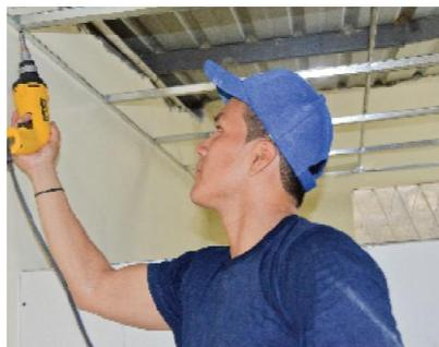
Figura 15 Colocación de omegas conectoras
