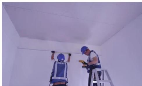
Figura 22 Colocación de ángulos primarios
