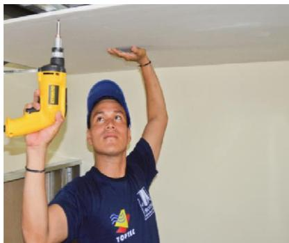
Figura 16 Anclaje de planchas de gypsum
