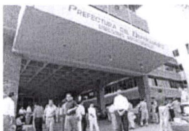
DEPENDENCIAS DE LA PREFECTURA • La fotografía muestra el frontis del edificio de la Prefectura de Santa Cruz.
