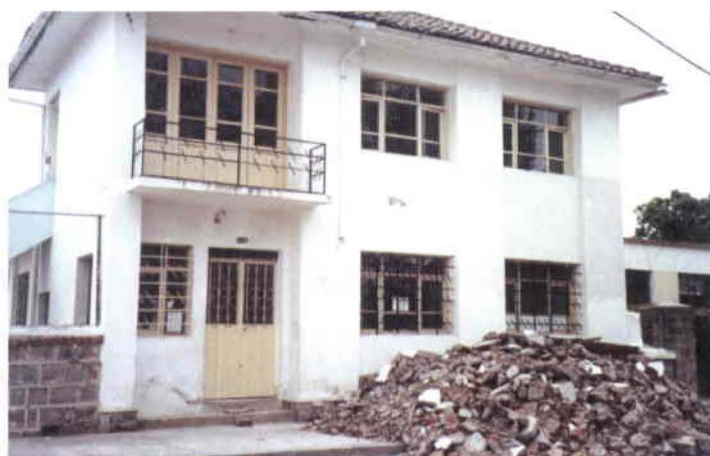
Obras de Remodelación de la Casa Municipal. FONSAL. Sept 2001
