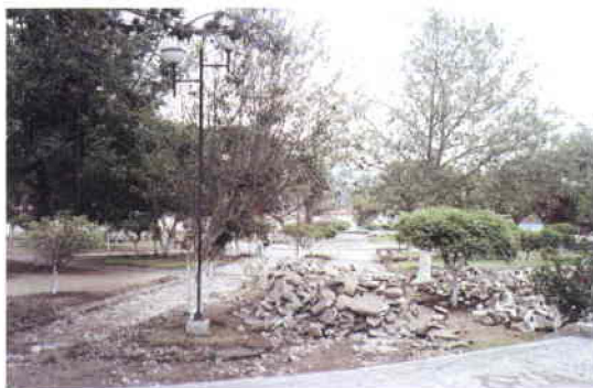
Obras de remodelación del Parque Central. FONSAL sept 2001
