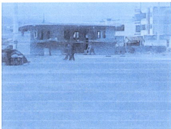
Fotografía de la Plataforma de Calderón que entrará en funcionamiento en diciembre 2012.
