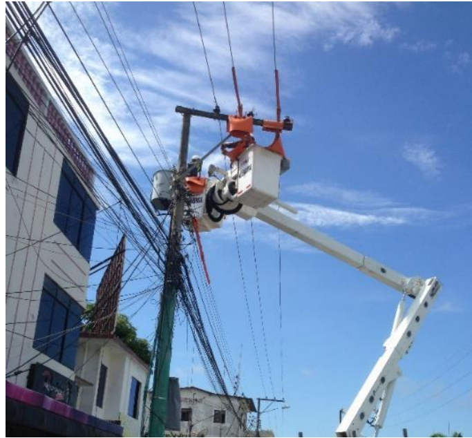
Figura 34. Cambio de Crucetas trifásicas sencillas
