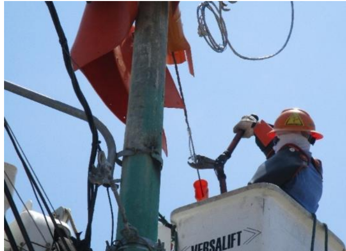
Figura 36. Cambio o instalación de conectores de compresión tipo “H”
