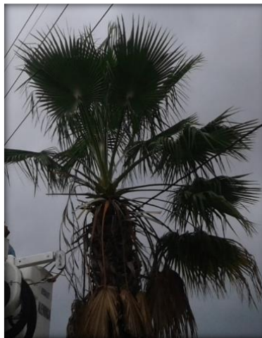
Figura 10. Vegetación sobre las líneas
