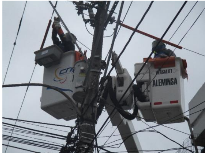
Figura 38. Instalación de estribos en U para transformador
