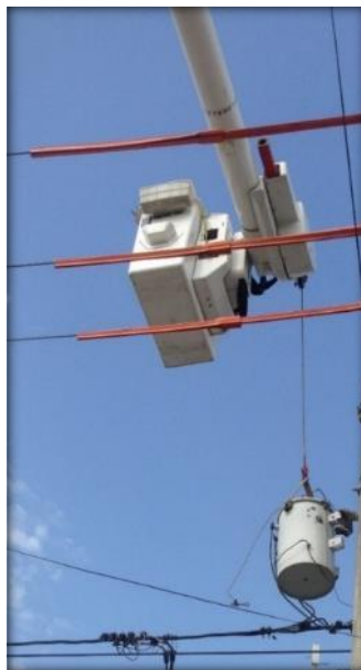
Figura 3. Cambio o montaje de transformador
