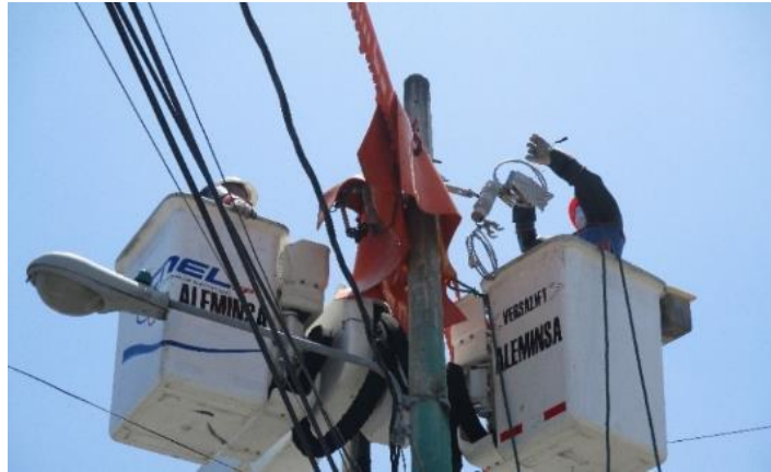
Figura 40. Cambio de seccionador e instalación de estribos
