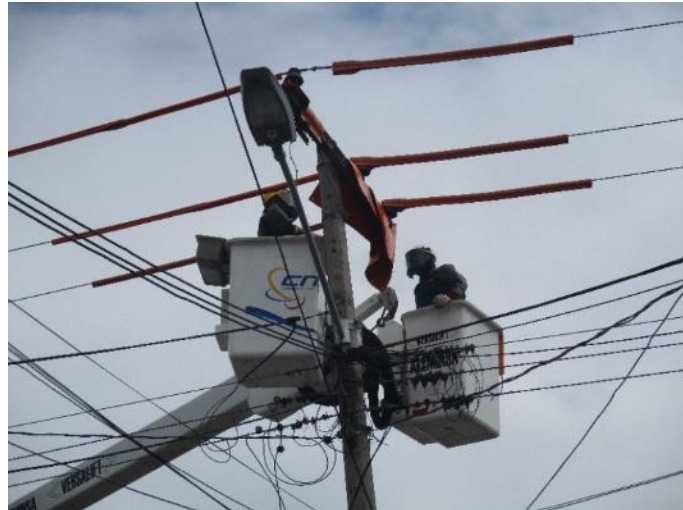
Figura 32. Cambio de aislador PIN
