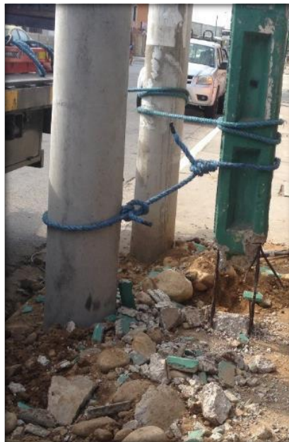
Figura 7. Cambio o intercalado de postearía
