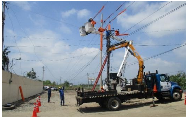
Figura 42. Cambio o intercalado de postes
