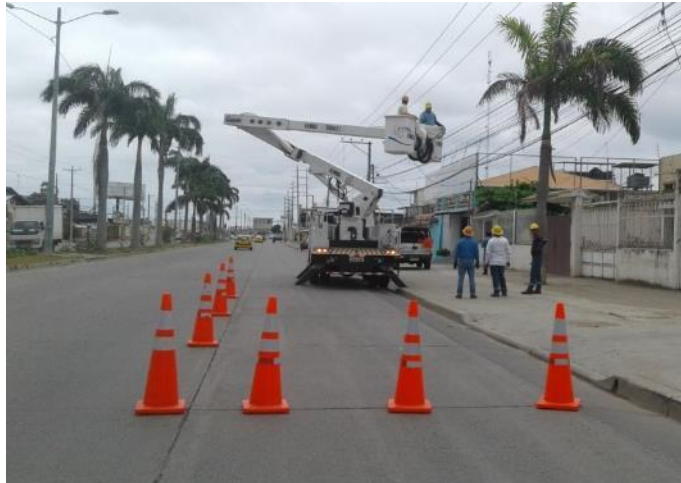
Figura 44. Desbroce de vegetación
