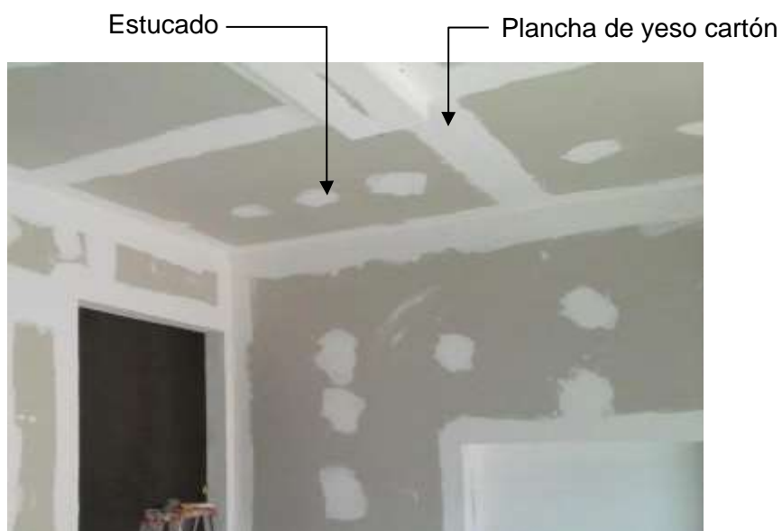
Figura 40. Encintado y estucado de Cielo Raso
