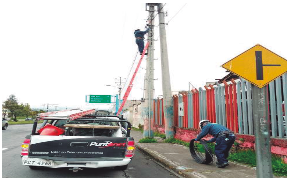
Figura 18. Instalación de fibra óptica.
