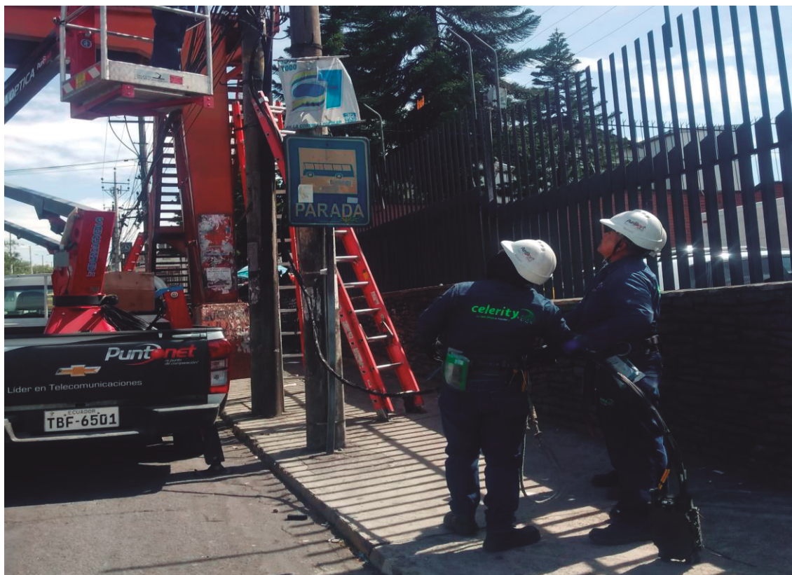
Figura 21. Instalación de manga en el poste.
