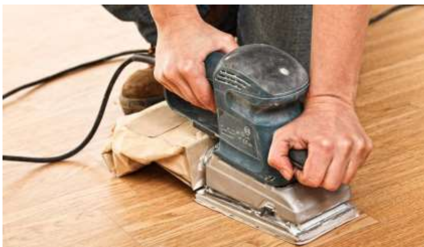
Figura 107. Lijado con Lijadora eléctrica.
