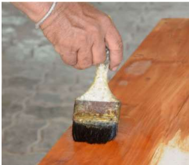
Figura 108. Lacado de madera con brocha.
