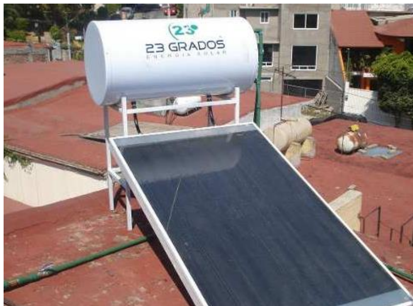
Figura 4: Colector solar plano. Tomado de: (CEMAER, 2016)
