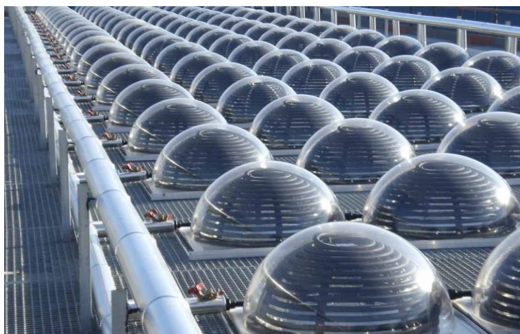
Figura 48: Colector solar semiesférico. Tomado de: (bubblesun, 2007)
