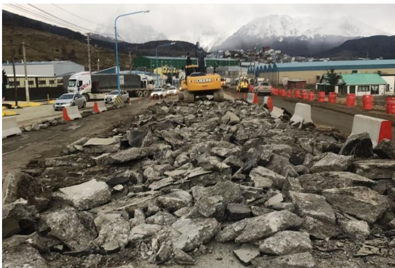
Figura 36. Remoción de asfalto
