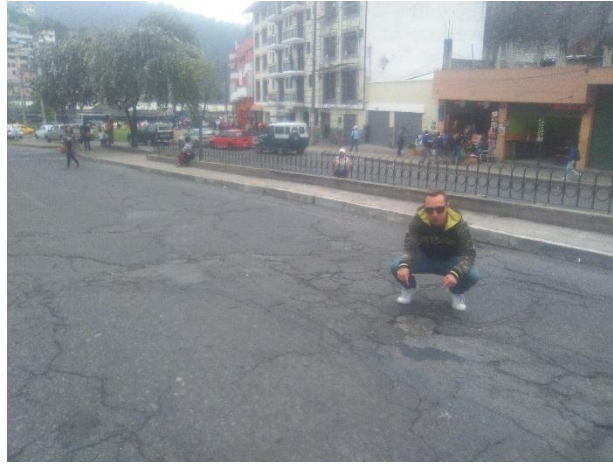
Bache en la avenida Sucre, longitud de la falla 60cm y profundidad 6cm
