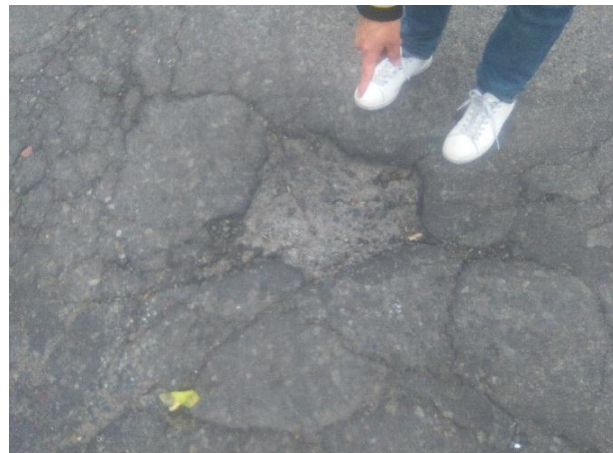
Bache en la avenida Sucre, longitud de la falla 60cm y profundidad 6cm
