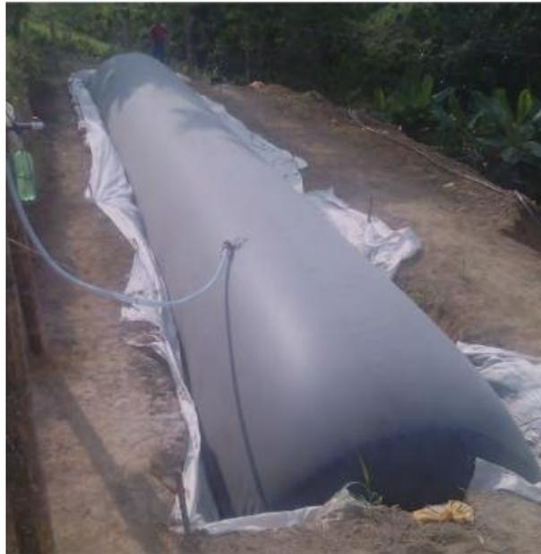
Figura 22. Biodigestor de geomembrana en granja porcina
