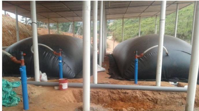
Figura 13. Biogestores en una explotación agrícola
