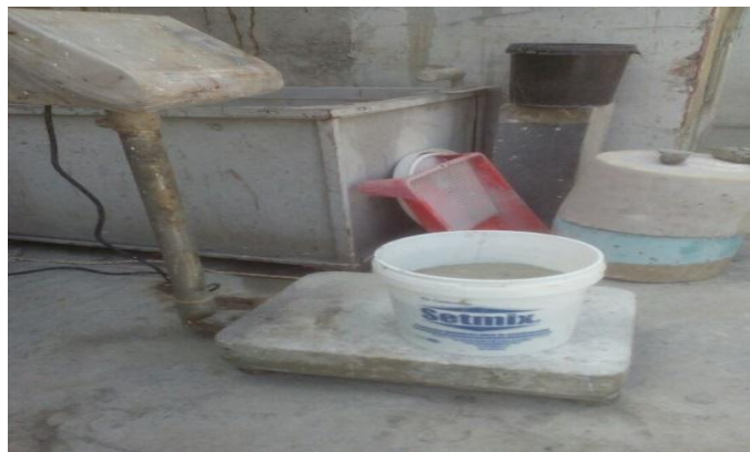
FIGURA 33. Pesaje de materiales para elaboración de hormigón.
