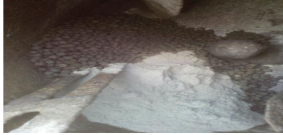
FIGURA 34. Colocación de materiales en mezcladora.
