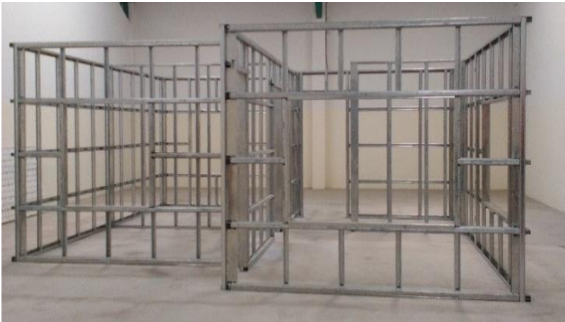
Figura 153. Estructura terminada vista 1
