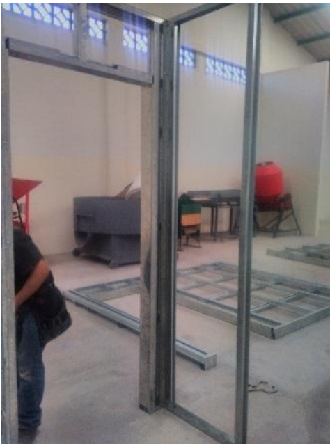
Figura 148. Unión del Panel pll-02 con los paneles pll-03 y pp-01
