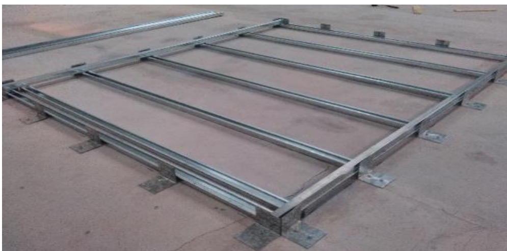
Figura 36. Isometría con Detalle Esquinero (parte superior) y Foto del Armado del Cuadro de Un Panel Doble (parte inferior)
