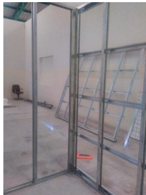
Figura 148. Unión del Panel pll-02 con los paneles pll-03 y pp-01
