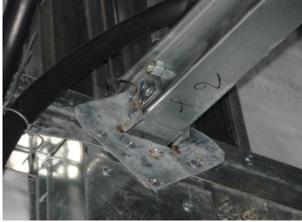
Figura 160. Unión de Cercha y Panel
