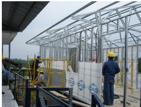
Figura 8. Construcción en Steel framing
