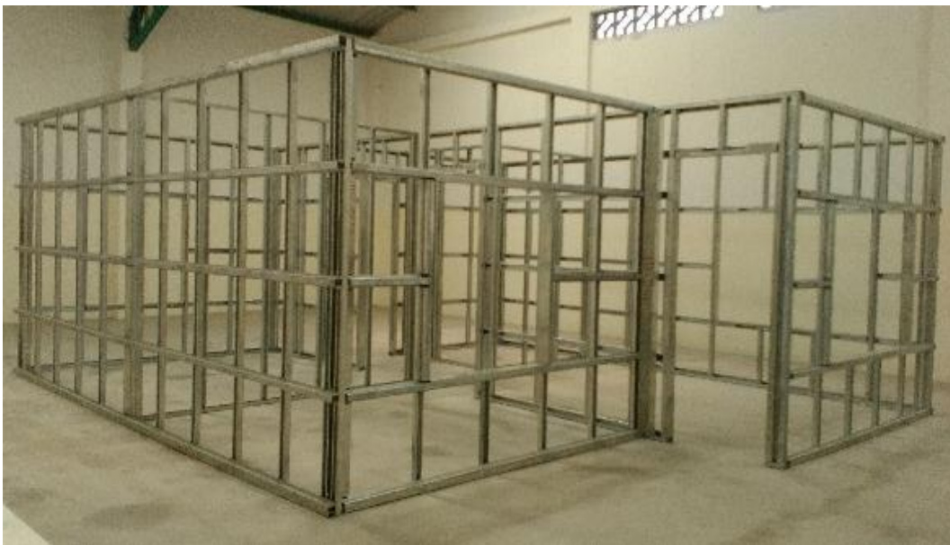
Figura 155. Estructura terminada vista 3
