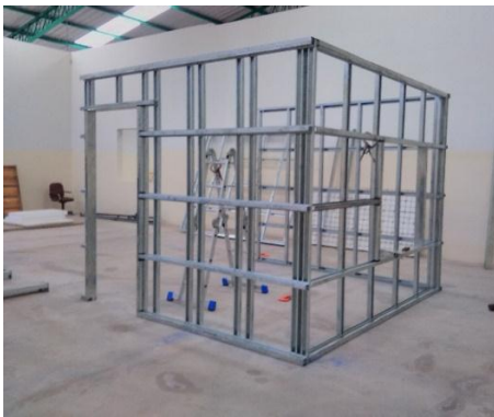
Figura 147. Unión de Paneles pv-01 y pp-01
