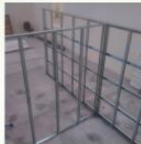
Unión del Panel pII-01 con los paneles pII-03 y pII-02
