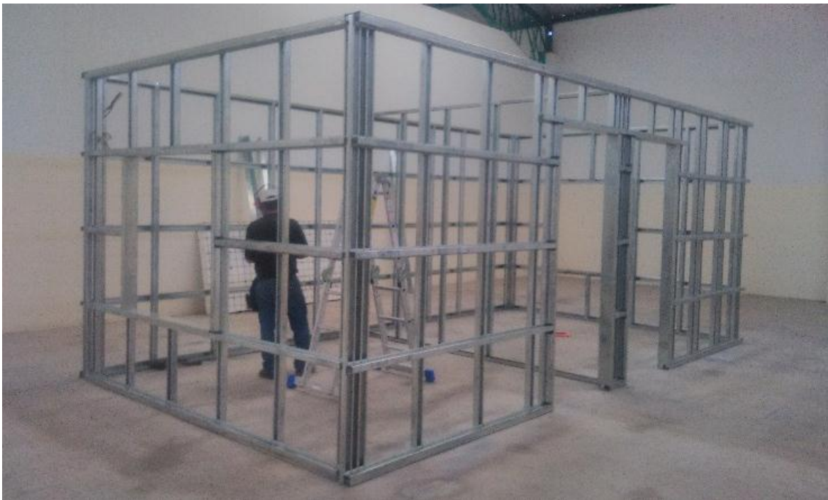
Figura 151. Unión del Panel pv-06 con los paneles pll-01 y pp-05
