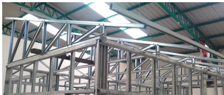
Figura 162. Colocación de cerchas cada 1220mm
