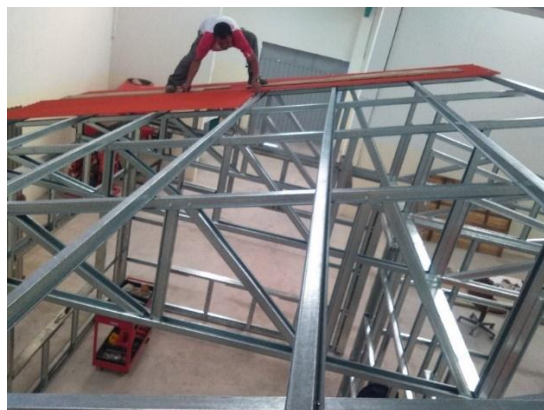
Figura 164. Colocación de Correas Sobre las Cerchas Cada 610mm
