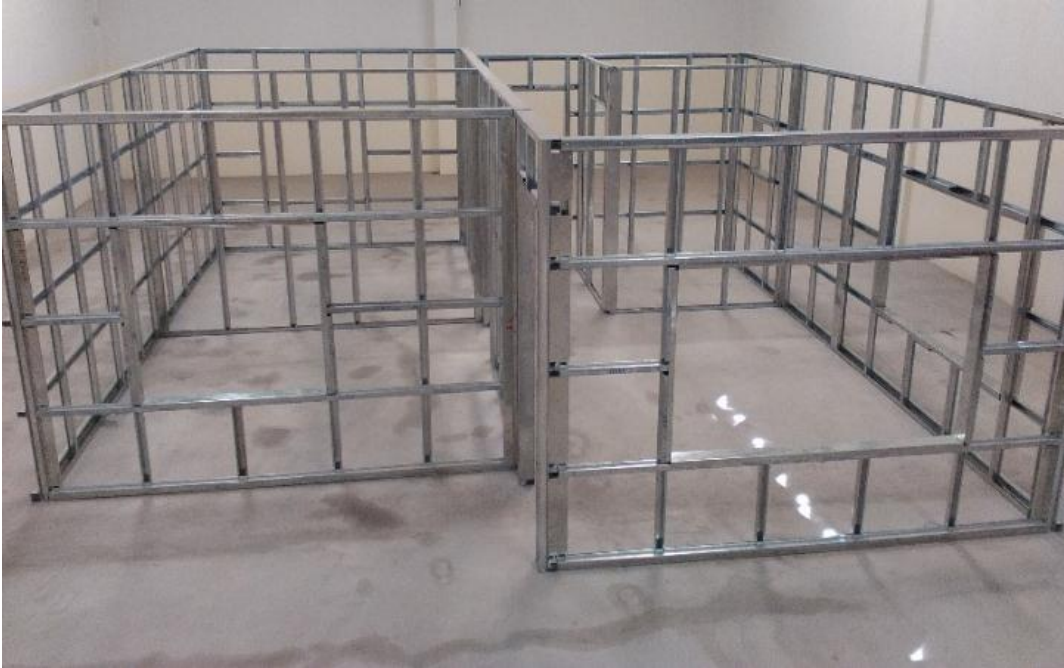
Figura 154. Estructura terminada vista 2
