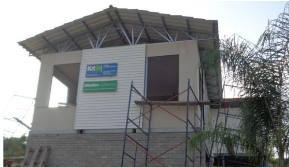
Figura 166. Recubrimiento con fibrocemento y syding (Pedernales)
