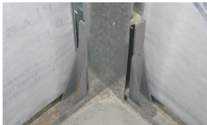
Figura 156. Sujeción del Panel Hacia el Piso
