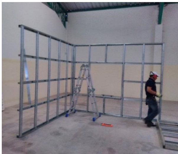
Figura 146. Unión de Paneles pII-03 y pv-01
