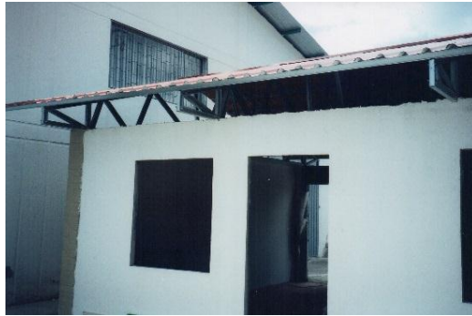
Figura 165. Recubrimiento con malla nervada con hormigón
