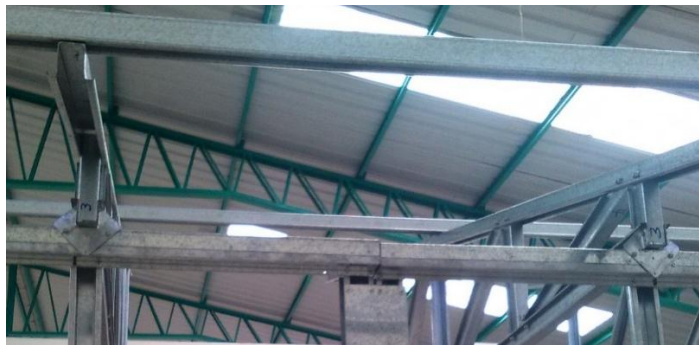
Figura 161. Colocación de cerchas cada 1220mm
