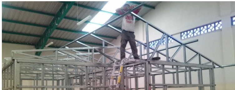
Figura 163. Colocación de Correas Sobre las Cerchas
