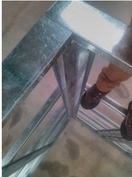
Figura 157. Vista de la unión de dos paneles en vista superior
