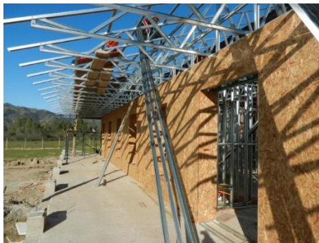
Figura 167. Recubrimiento con OSB (Petro Bell)
