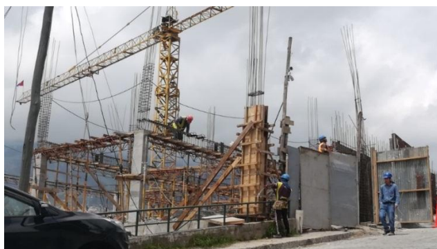
Figura 5. Construcción Tradicional Racionalizada
