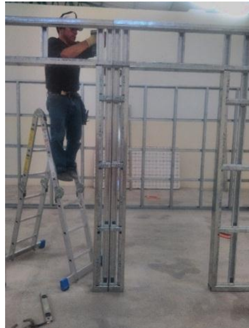
Figura 150. Unión del Panel pp-05 con los paneles pll-02 y pp-01
