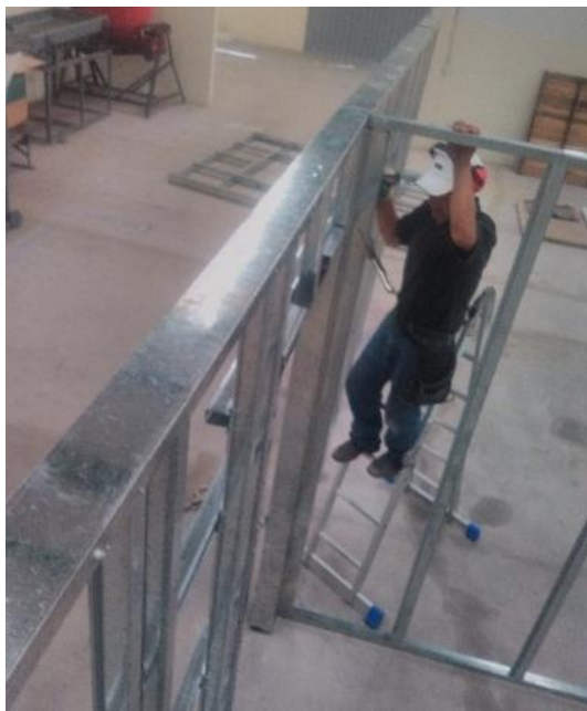
Figura 150. Unión del Panel pp-05 con los paneles pll-02 y pp-01
