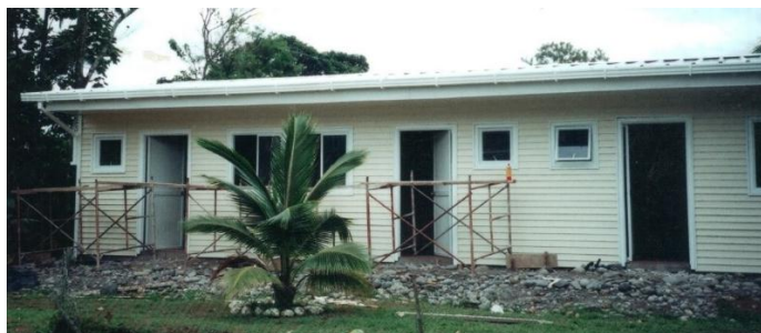
Figura 168. Recubrimiento con Syding sobre OSB (Petro Bell)
