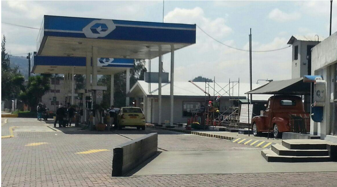
Figura 2. Estación de Servicios de Combustibles.
