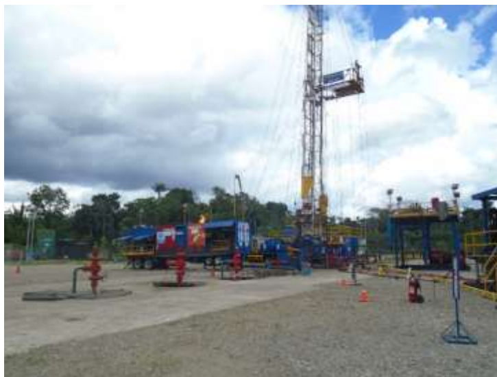
Figura 4. Rig 101 Taladro de Reacondicionamiento de pozos petroleros.
