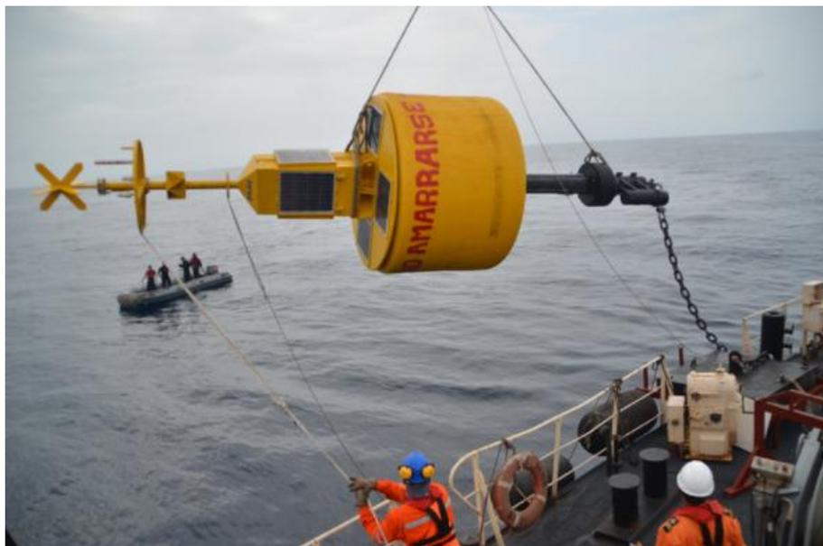
*Figura 94.* Posicionamiento de Boya para la detección de Tsunami - Esmeraldas – Ecuador
