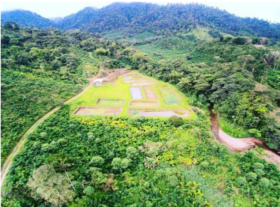
Figura 3. Instalaciones "Gran Manantial" 2/2
