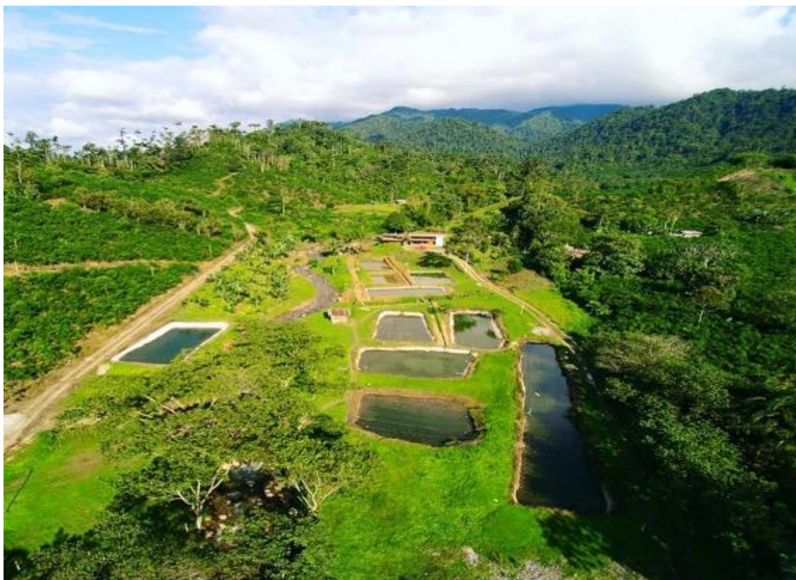
Figura 2. Instalaciones "Gran Manantial" 1/2
