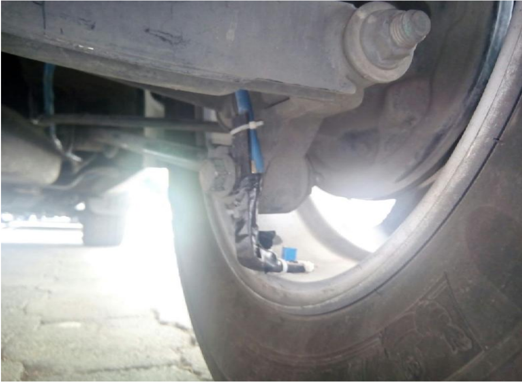
Figura 45. Ubicación física del sensor de efecto hall a estructura metálica
