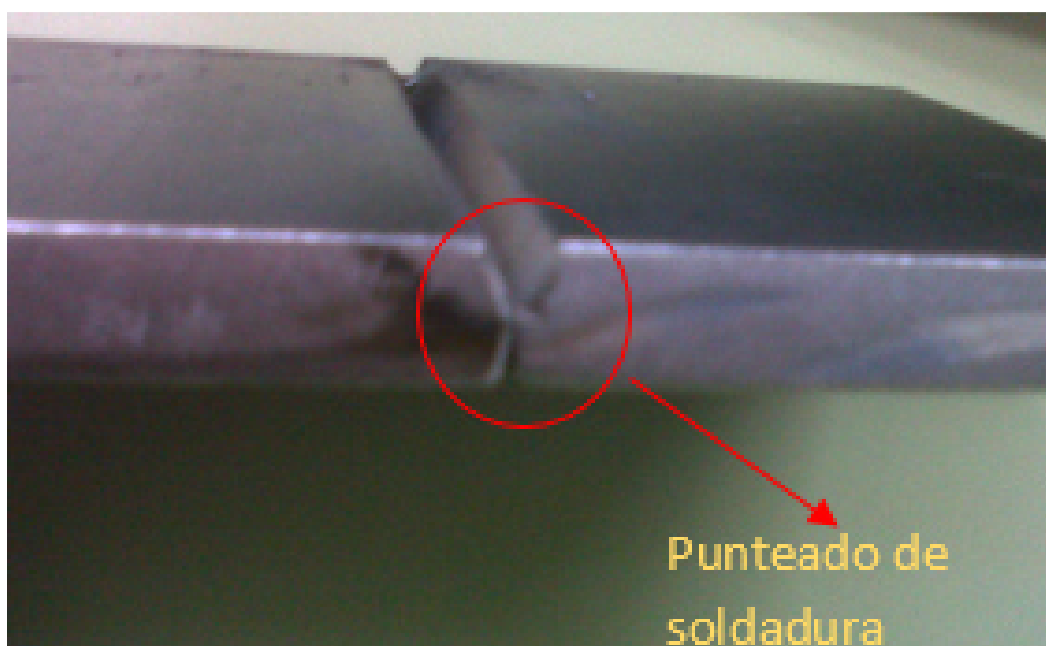
Figura 33. Ejemplo de punteado de soldadura. Tomado de (Pereda, 2013)
