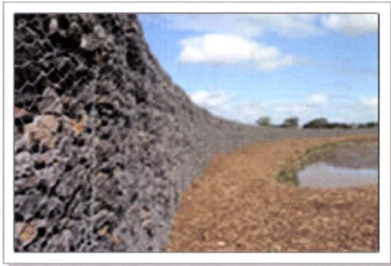
Foto: Muro de Contención hecho a base de Gaviones
