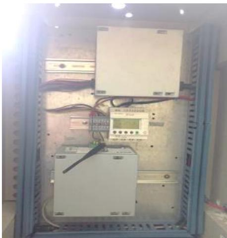
Figura 71. Fotografía del interior del tablero de control RTU Alma Lojana Bajo.
