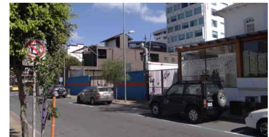
Figura.76: Edificación patrimonial a lado del lote a intervenir
