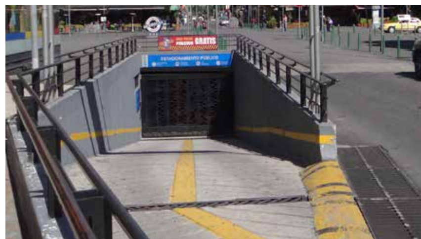
Figura.82: Estacionamiento en subsuelo
