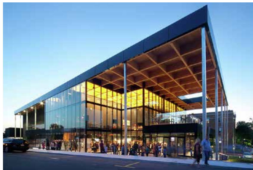
Figura.45: Vista exterior del desarrollo de actividades Tomado de (Plataforma arquitectura, 2015)
