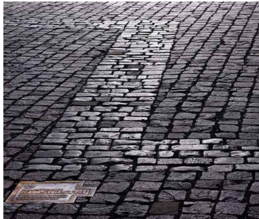
Figura.26: Tratamiento de piso plaza Frydlant Tomado de (Plataforma Arquitectura, 2014)
