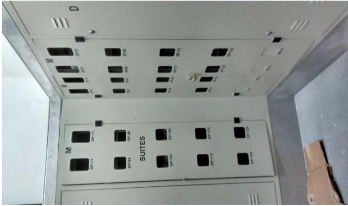
Ducto de medidores de Luz
