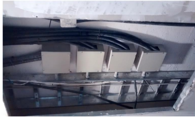
Ducto de medidores de Luz
