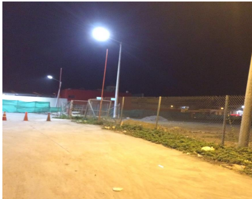
Figura 8. Parqueadero de zona comercial del terminal
