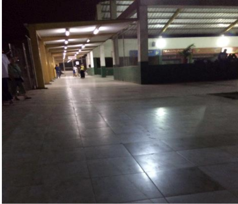
Figura 91. Circulación sin iluminación
