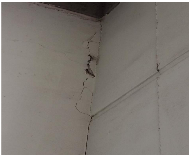
Figura 80. Paredes del terminal
