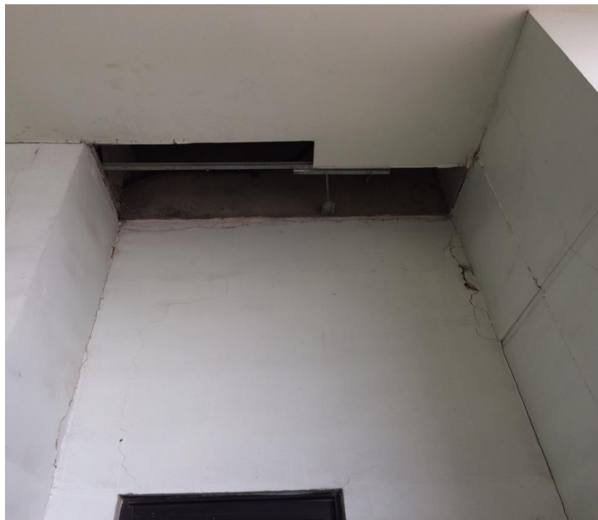
Figura 85. Techo de Gypsum
