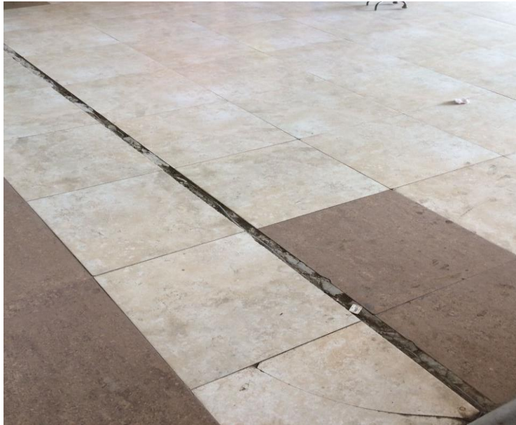
Figura 83. Piso de Porcelanato
