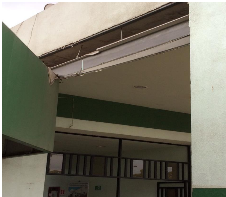
Figura 87. Techo de Gypsum.
