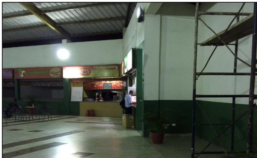
Figura 79. Paredes del terminal
