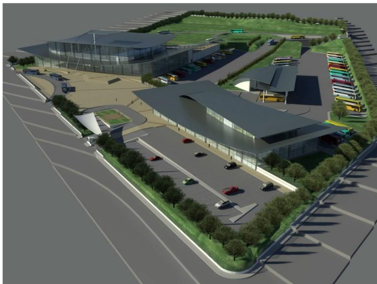
Figura 27. Terminal terrestre Sur Adaptado de (El Herald, 2014)
