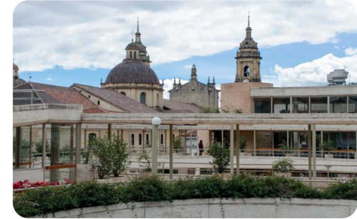
Figura 71. Centro Cultural Garcia Marquez. Tomado de (Plataforma Arquitectura, s,f)
