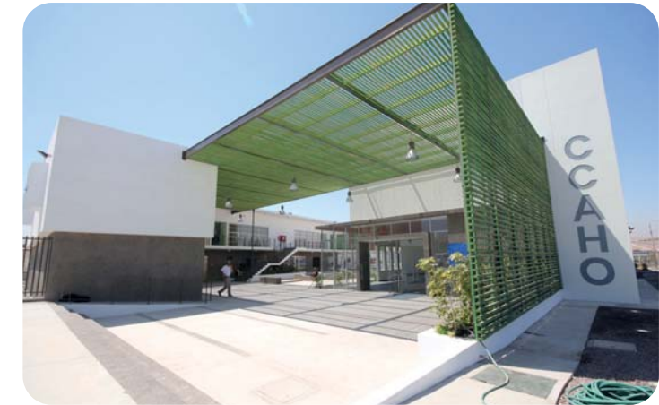
Figura 89. Centro Cultural Alto Hospicio. Tomado de (Plataforma Arquitectura, s,f)
