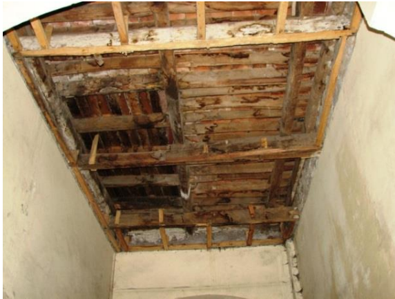
Figura 2. Fotografía del entre piso en su planta baja
