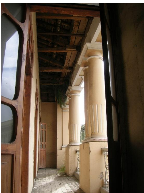
Figura 70. Fotografía interior de la cubierta del Teatro León
