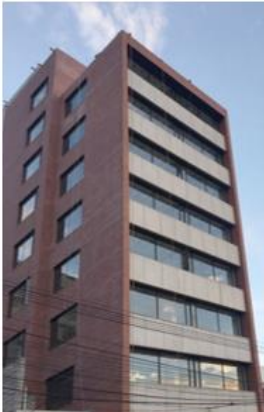
Fachada Frontal y Lateral del edificio
