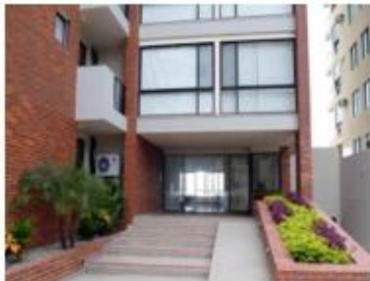
Ingreso peatonal al edificio
