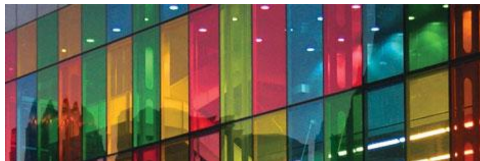
Figura 37. Vidrios Fotovoltaicos amorfo de colores
