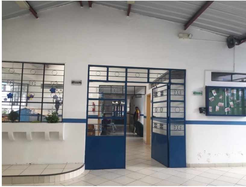
Figura 9. Ingreso 2 oficinas y aulas del Infa de Latacunga.
