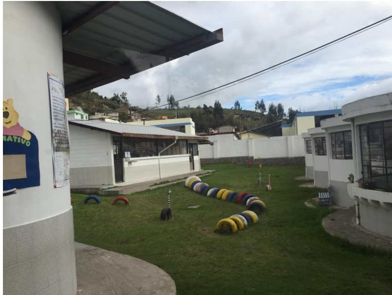
Figura 7. Aula y patio interior del Infa de Latacunga.
