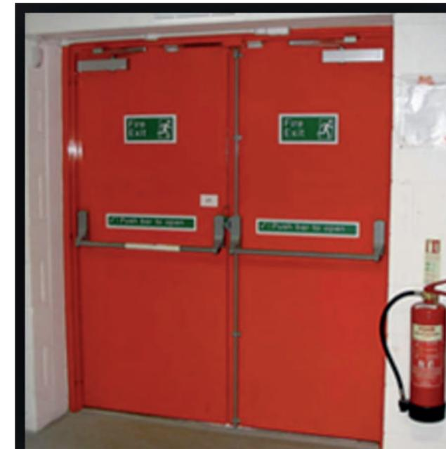
Los extintores de incendios se colocarán en las proximidades de los sitios de mayor riesgo o peligro, de preferencia junto a las salidas y en lugares fácilmente identificables y accesibles desde cualquier punto del local, considerando que la distancia máxima de recorrido hasta alcanzar el extintor mas cercano será de 25m.
