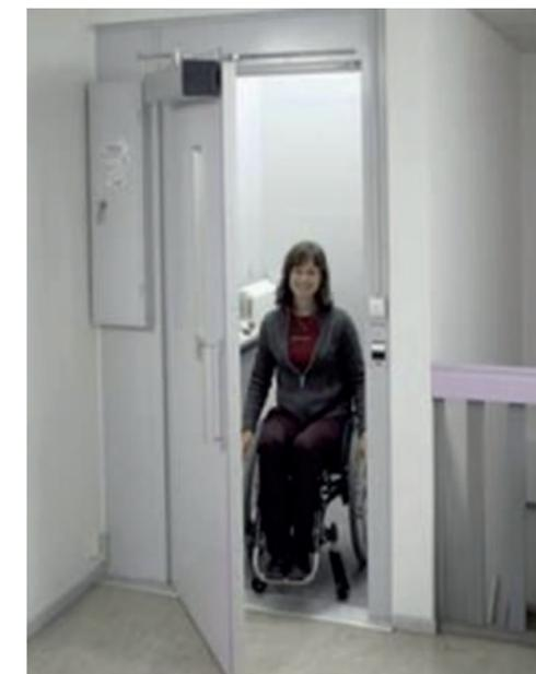
Las agarraderas de las puertas y sus cerraduras deben ser fáciles de manipular por las personas con capacidades reducidas, las puertas deben tener una barra horizontal ubicada entre 0.80 m y 1,20 m del nivel de piso terminado.
