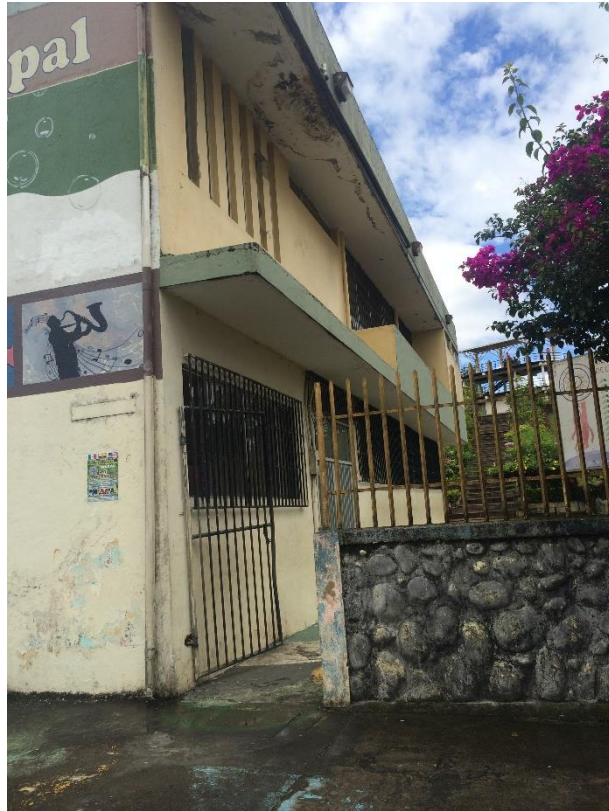
Figura 3. Fachada lateral derecha del Centro Cultural Municipal
