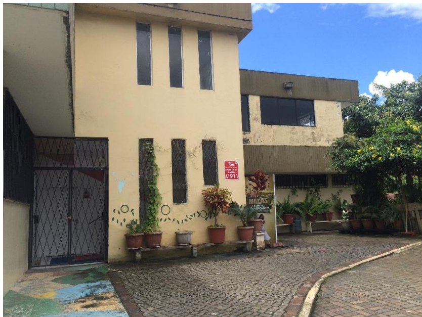
Figura 2. Fachada lateral derecha del Centro Cultural Municipal
