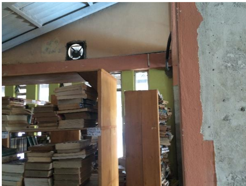
Figura 11. Ventilación e iluminación natural en la biblioteca
