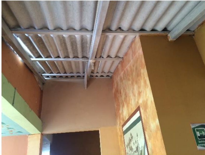
Figura 7. Cielo falso e iluminación en circulaciones planta alta
