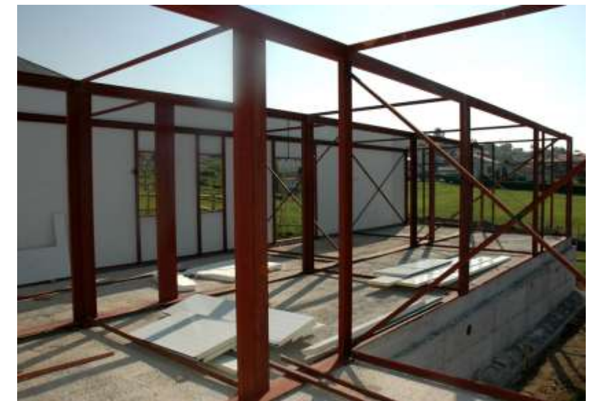
Figura 93. Prefabricado con acero.
