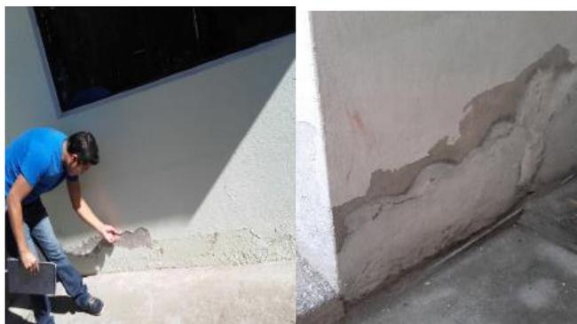
Figura N° 35 Imagen del linchamiento de la pintura por humedad
