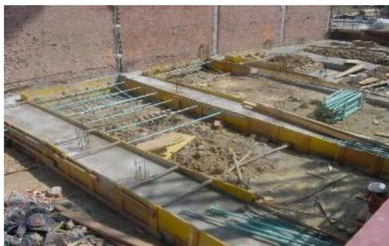
Figura N° 21 Cimientos flotante.
