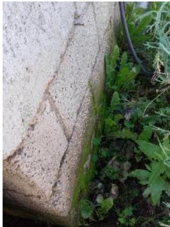
Figura N° 36 Imagen de filtración de agua
