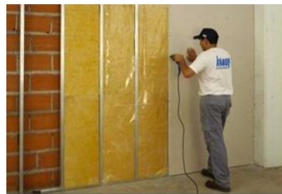
Figura 60. Instalación de la fibra de vidrio Tomado de: (INEN , 2015)
