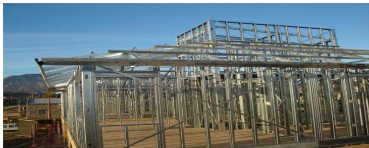
Figura 4. Estructuras de Steel Frame
