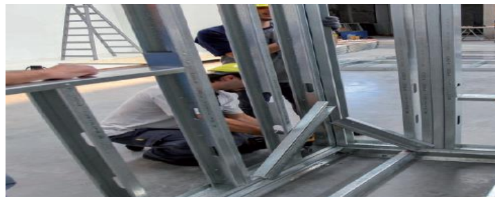
Figura 6. Estructuras metálicas Tomado de: Manual Instructivo Steel Framing.
