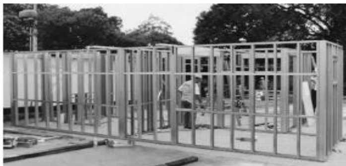
Figura 2. Paneles sobre el suelo de tierra de vivienda habitacional Belo Horizonte Tomado de: (Freitas, 2015, pág. 15)
