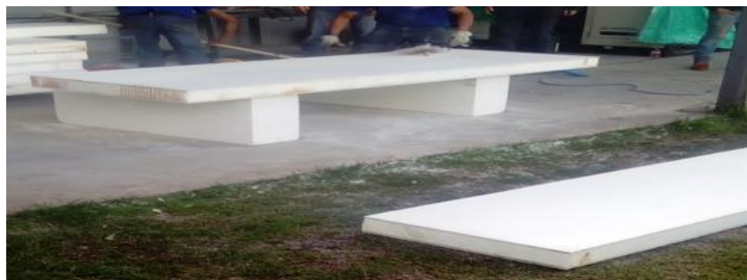
Figura 56. Instalación placas de Zip Wall
