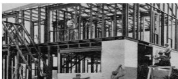
Figura 1. Prototipo de residencia en Light Steel Framing en la Exposición Mundial de Chicago en 1933 Tomado de: (Marshall, 2016).
