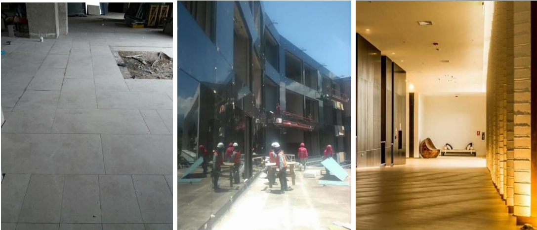
Colocación de porcelanato en pisos, Colocación de vidrios, Terminado de paredes.
