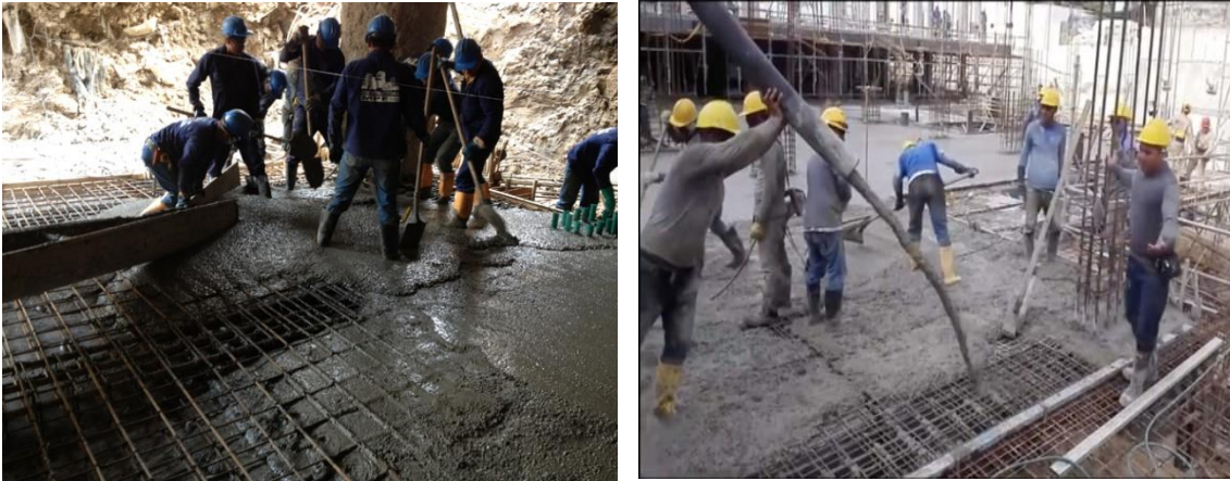
Preparación de concreto, Vaciado de concreto con bomba.
