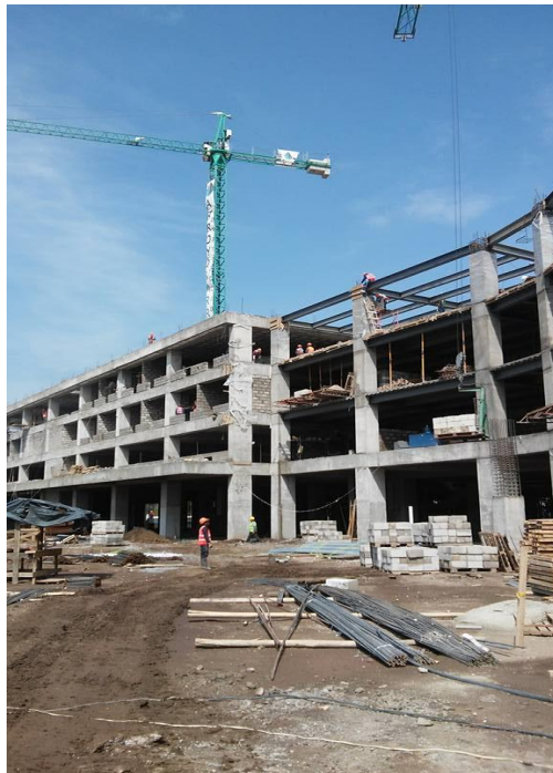
Carga de material con torre grúa.
