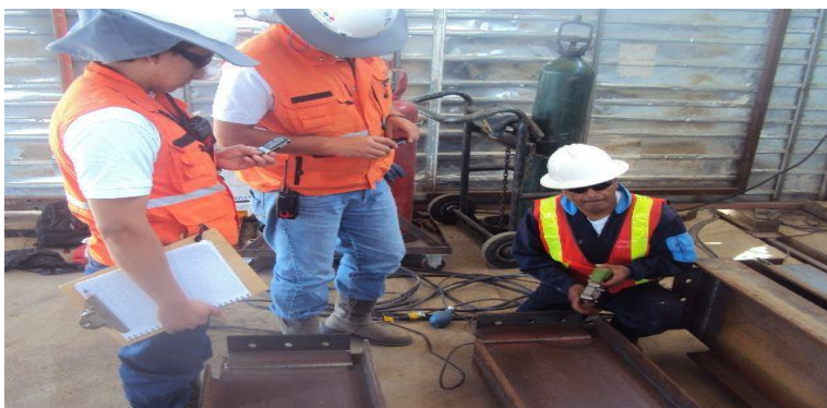
Figura N° 8. Capacitación y sensibilización del personal de obra
