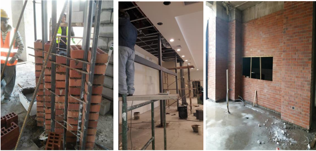
Muros de Bloque, Conformación de muros de ladrillo, Cielos rasos planos.
