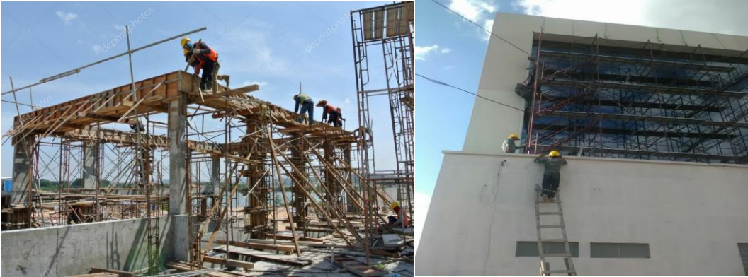
Encofrado y desencofrado, Armado de andamios
