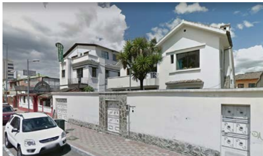
Figura 205. Fotografía del terreno.
