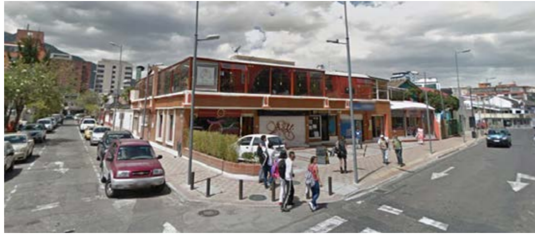
Figura 203. Fotografía del terreno
