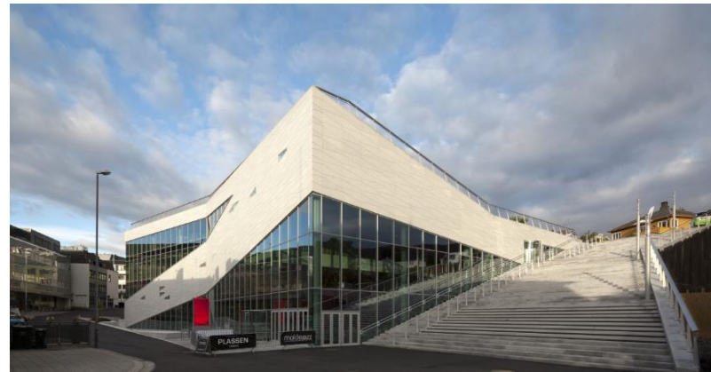
Figura 53. Centro cultural Plassen. Tomado de: Plataforma Arquitectura.
