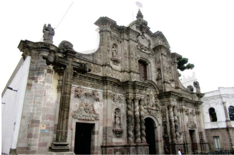
Figura 43. Vista lateral de la Iglesia de la Compañía. Tomada con Canon Powershot.
