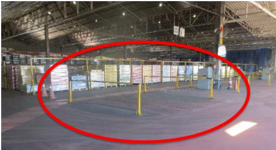
Figura 45. Barreras Zona de Preparación, Centro de Distribución Florianópolis Tomado de: AB InBev (2008)
