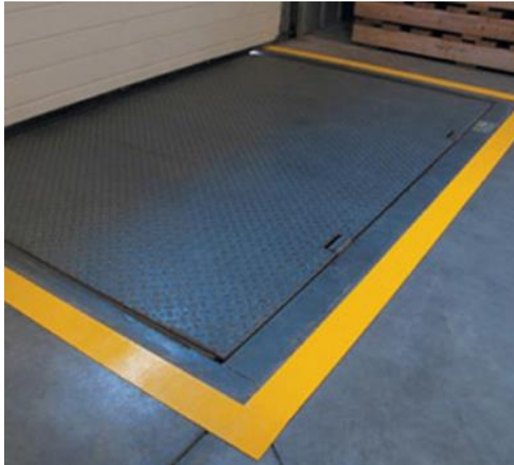
Figura 52. Poka Yoke de Delimitación de Espacio para Rack y Escalera Móvil Tomado de: Premiumcorp (s.f)
