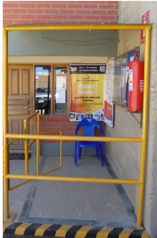
Figura 49. Propuesta de área segura para conductores Tomado de: Centro de distribución Oruro AB InBev (2015)
