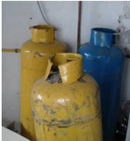
**Fotografía 6.- Cilindros de gas 45kg.
