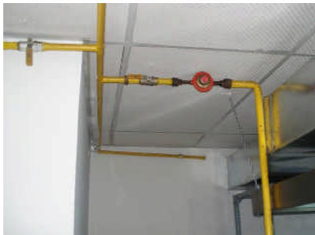
**Fotografía 7.- Tubería para gas.
