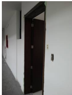
Figura 125, Construcción de puerta Edificio Vivalto.
