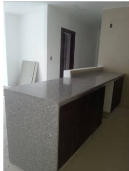
Figura 112, Mesón de granito Edificio Vivalto.
