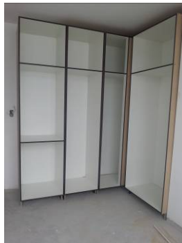
Figura 126, Construcción de closets Edificio Vivalto.
