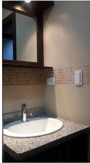
Figura 16, Revestimiento de porcelanato en baños Edificio Vivalto
