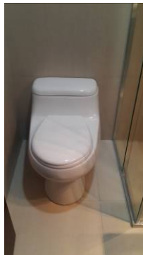
Figura 48, Inodoro en departamentos Edificio Vivalto.
