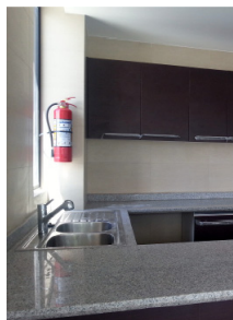
Figura 34 , Fregadero de acero inoxidable en departamento Edificio Vivalto.
