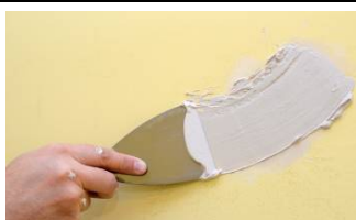
Figura 73, Corrección de grietas en mampostería. Tomado de Pinto mi casa, 2008
