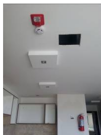
Figura 90, Instalación muebles altos Edificio Vivalto.
