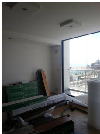
Figura 59, Piso laminado de origen alemán Edificio Vivalto.
