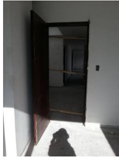
Figura 124, Construcción de puerta Edificio Vivalto.
