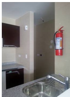
Figura 37, Fregadero de acero inoxidable en departamento Edificio Vivalto.
