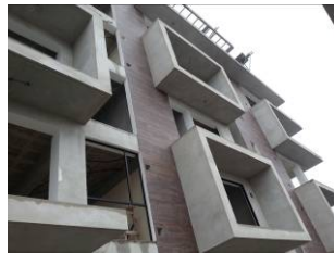
Figura 131, Vanos de ventana Edificio Vivalto.
