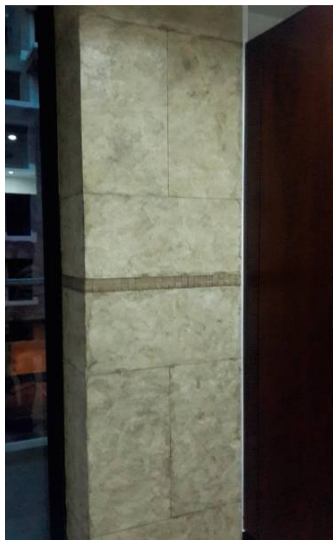
Revestimiento de travertino
