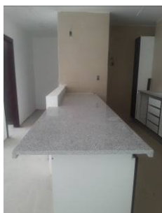
Figura 110, Mesón de granito Edificio Vivalto.
