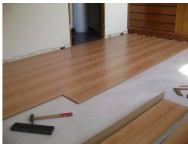
Figura 61 , Colocación de piso laminado. Tomado de Iguana fix., s.f.
