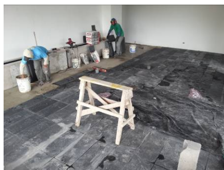
Figura 69, Colocación de porcelanato Edificio Vivalto.
