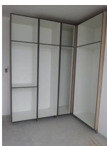
Figura 115, Armado de closet Edificio Vivalto.
