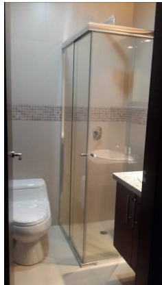
Figura 49, Inodoro en departamentos Edificio Vivalto.
