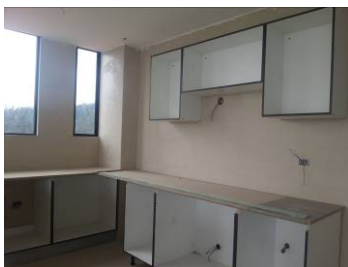
Figura 109, Madera contrachapada de 3/4" en la parte superior de muebles de cocina Edificio Vivalto.
