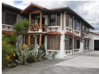
Figura 5, Combinación de ladrillo y madera en construcción. Tomado de Ec.clasificados, 2009
