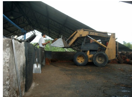
Fotografía # 2: Tolva de alimentación
