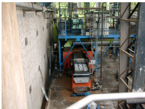
Fotografía # 10: Tamiz de prensado
