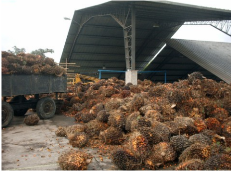
Fotografía # 1: Plataforma de descarga
