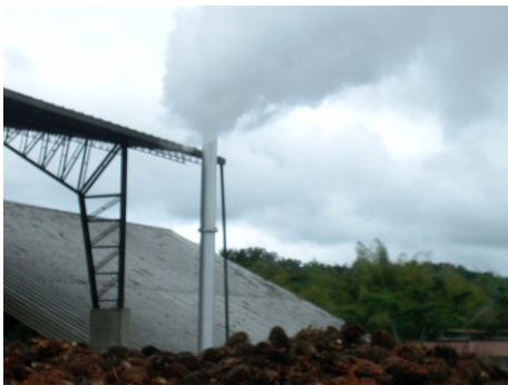
Fotografía # 26: Chimenea de vapor
